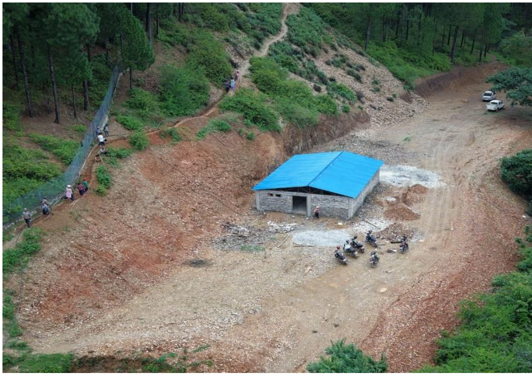
निर्माणाधीन गौसाला भवन
